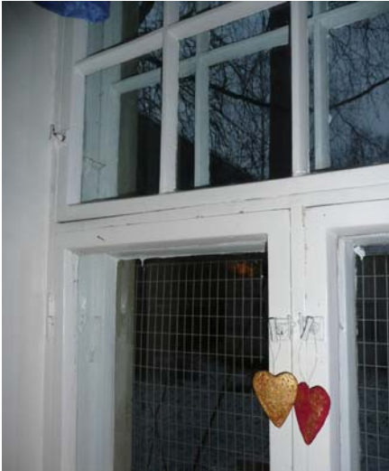
Eteläjulkisivun ikkunat ovat luultavasti alkuperäiset
