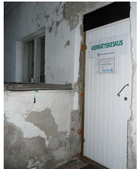
Uusittu puu-ulko-ovi kiviosassa johtaa Marttojen kierrätyskeskus-mehuasemalle.
