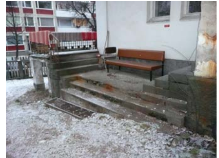
Pohjoispuolen luonnonkiviportaatt ovat ensimmäisestä rakennusvaiheesta.
