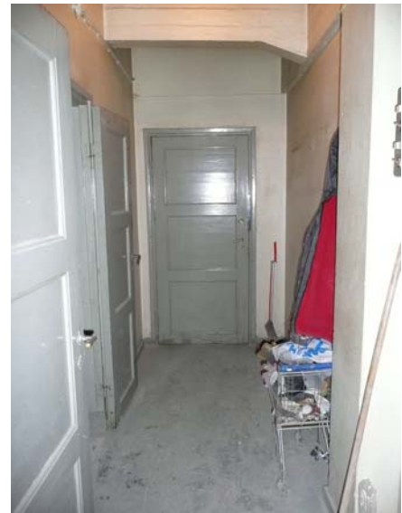
Eteiskäytävän alkuperäisiä puupeiliovia
