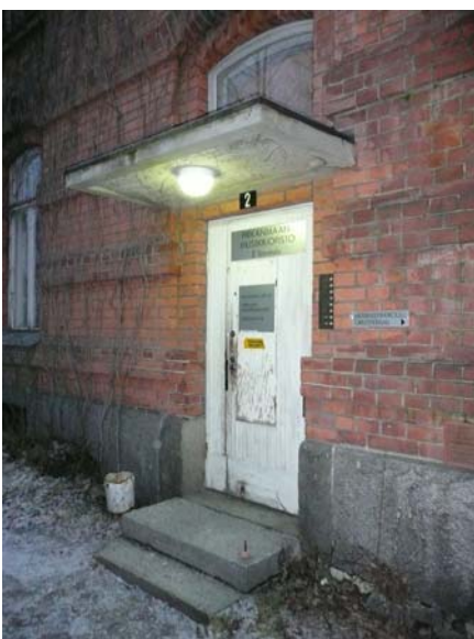
Eteläjulkisivun ulko-ovi, joka johtaa nykyiseen pääportaikkoon. Sisäänkäynti puhkaistiin julkisivuun 1950-luvulla. Samalla rakennettiin oven ylle betoninen katos.
