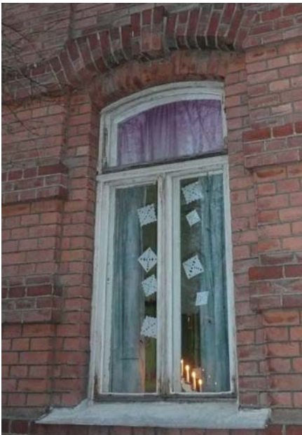
1. kerroksen alkuperäinen T-ikkuna
