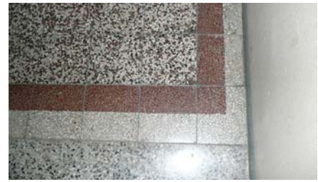
Alkuperäisten porrastasanteiden reunoja kiertää punainen ja harmaa sementtimosaiikkiraita.
