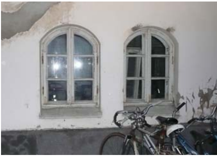
Kellarikerroksen ikkunat ovat alkuperäiset.
