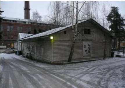
Desinfiomislaitos-piharakennuksen pohjois- ja länsijulkisivut.
