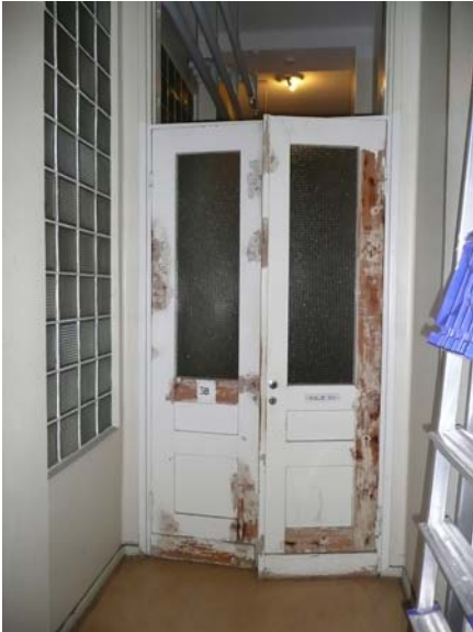
Alkuperäinen lasiaukollinen peilipariovi 1. kerroksen käytävällä.
