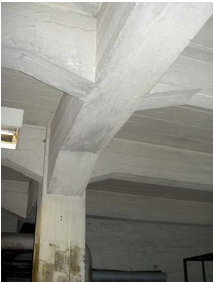
Rakennuksen lautamuottiin paikallavaletut betoniset kattopalkit ja pilarit
