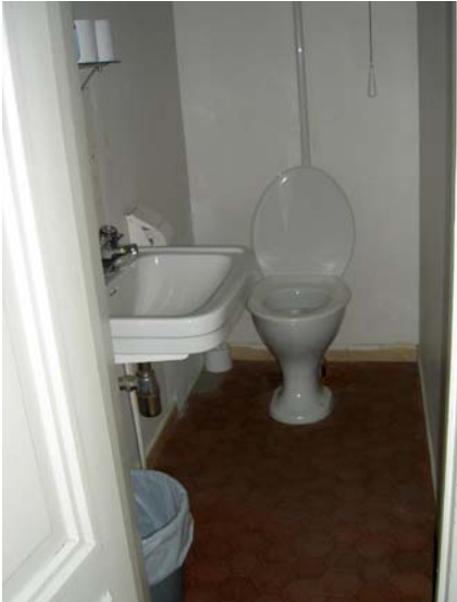
WC-tiloissa saniteettikalusteet ja pintamateriaalit ajoittuvat 1950-luvulle, vesikalusteet on uusittu mahdollisesti 1980-luvulla.
