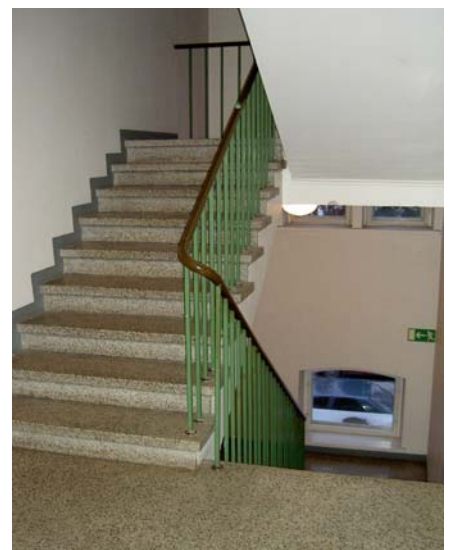
Nykyinen pääportaikko tehtiin rakennukseen 1950-luvulla. Portaatt ja tasanteet ovat sementtimosaiikkia.
