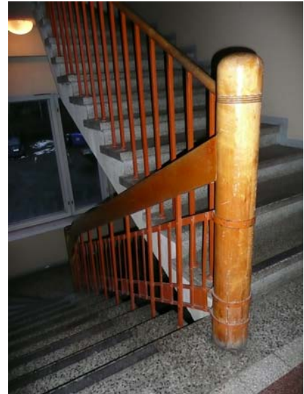
1. ja 2. kerroksen välinen välitasanne. Alaspäin vievän portaan askelmat, kaide ja kaidetolppa ovat alkuperäiset. Ylös johtava porras kaiteineen on puolestaan 1950-luvun muutosvaiheesta.
