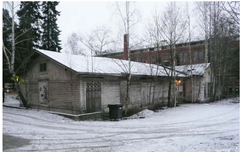
Etelä- ja länsijulkisivut. Ovi ja osa ikkunoista on peitetty levyllä. Eteläjulkisivun vasemmanpuolisimman oven yläpuolella näkyy alkuperäinen pikkuruutuinen yläikkuna. Piirustusten mukaan kaikkien ovien yläpuolella on alunperin ollut samanlainen.
