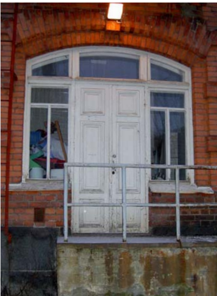
Itäjulkisivun ulko-ovi on todennäköisesti alkuperäinen
