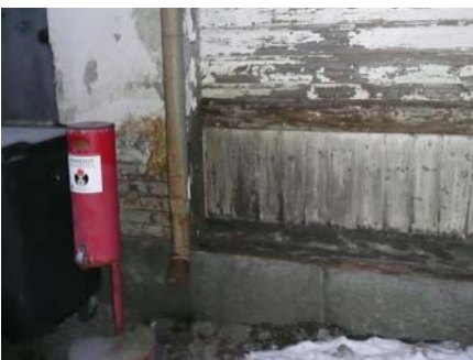
Kivi- ja puuosan liittymä pohjoisjulkisivussa
