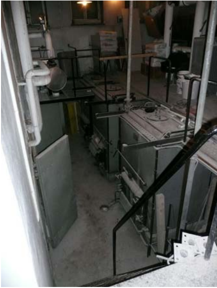
Entinen kattilahuone on osin kahden kerroksen korkuinen.
