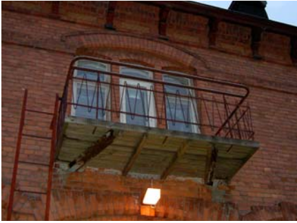
Molempiin päätyihin lisättiin parvekkeet 1950-luvulla. Kuvassa itäjulkisivun puurakenteinen metallikaiteinen parveke.
