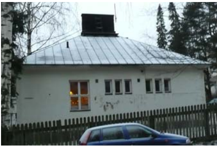
Pohjoisjulkisivussa on alkuperäisten piirustusten mukaan ollut kolme kolmen ikkunan riviä. Vasen ikkunarivi on 1950-luvulla korvattu 4-ruutuisella ikkunalla.
